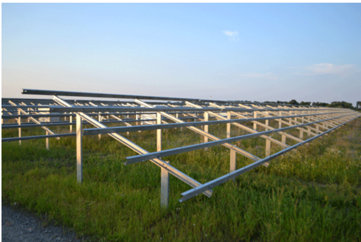
Fot. 2. Przykładowa stalowa konstrukcja gotowa do montażu paneli fotowoltaicznych. Zdjęcie www.projekt-solartechnik.pl .
