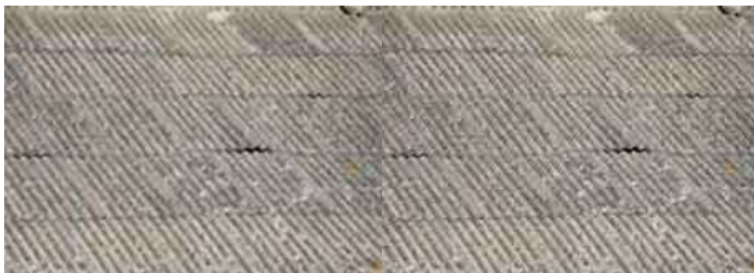
Rys. 5 Płyty faliste - eternit
