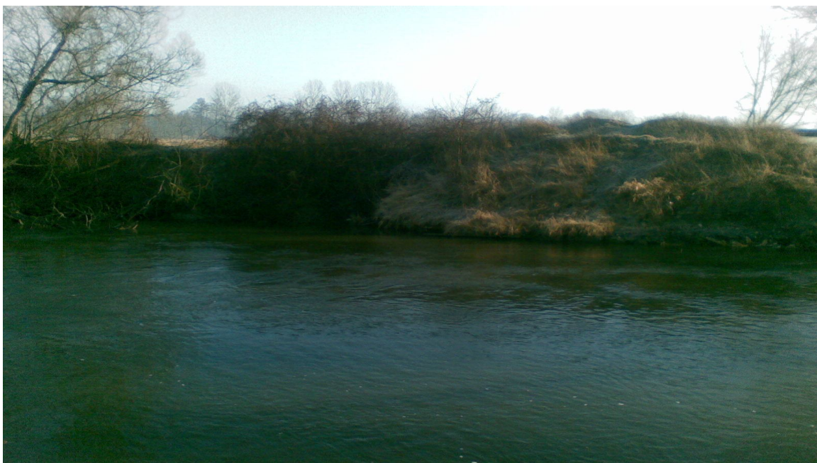
Fot. 1 Widok miejsca lokalizacji nowego obiektu (nasypy na brzegach pozostałe z rozbiórki dotychczasowego mostu)
