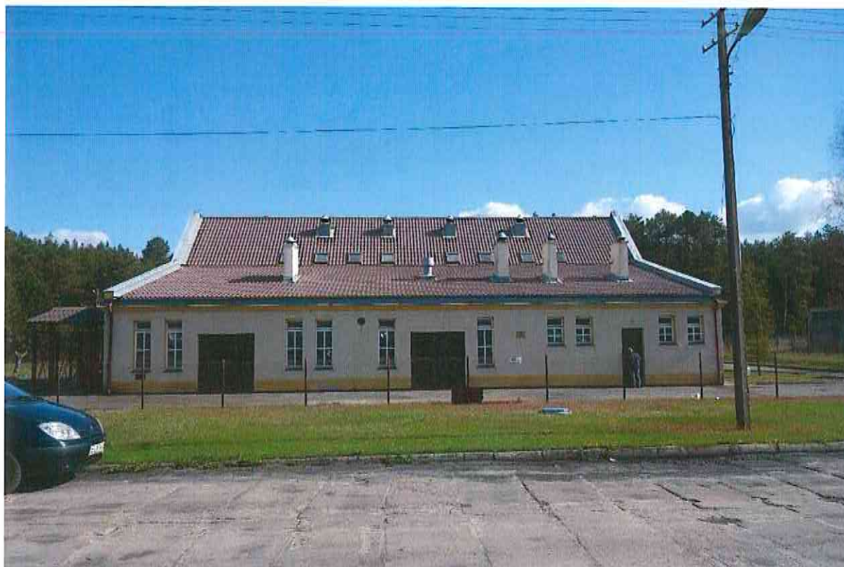
Zdjęcie 25. Dach Oczyszczalni Ścieków w Widawie
