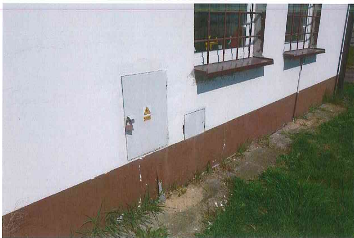
Zdjęcie 14. Lokalizacja przyłącza energetycznego
