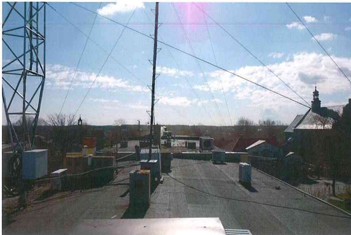
Zdjęcie 5. Zdjęcie dachu Urzędu Gminy w Widawie
